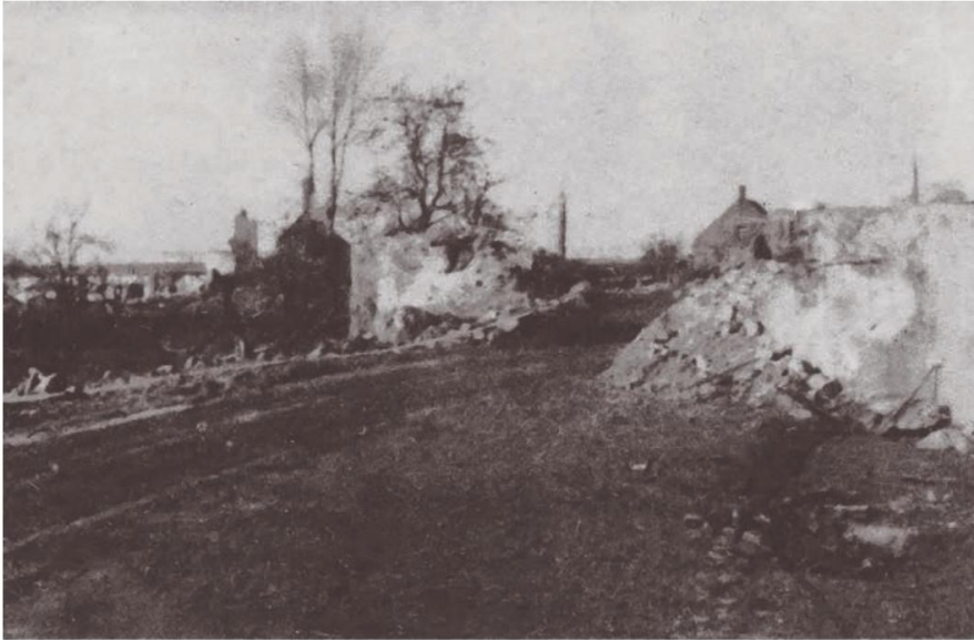
Betonnen barrière op de weg voor Moerdijk verwoest door brand van 10 psk80
